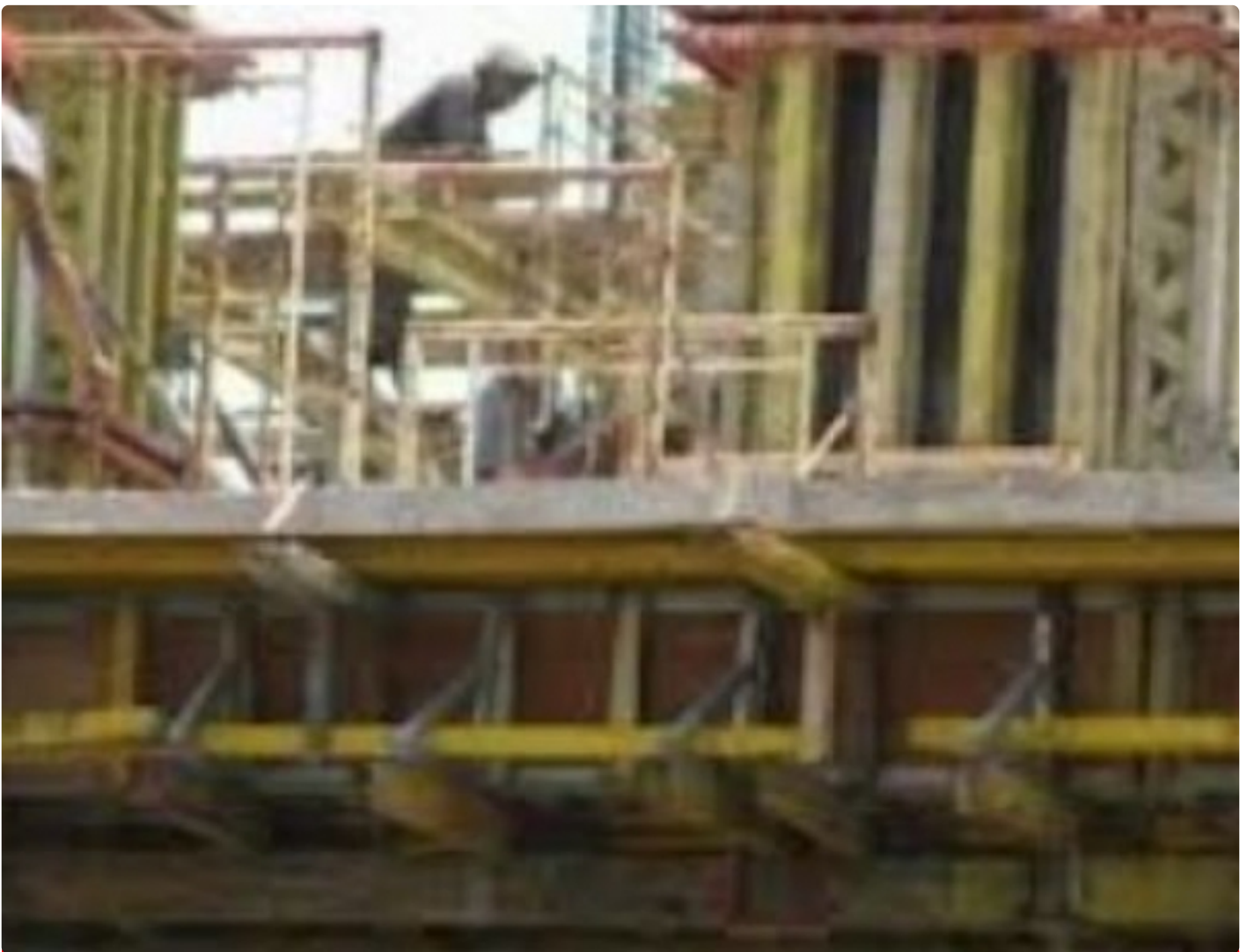
Banguna Rumah Sakit Tumbang Samba, Katingan Saat Pembangunannya
